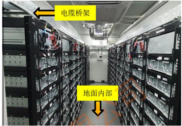
■ ESS 设备的电池室电缆桥架 & 地面内部电缆桥架
