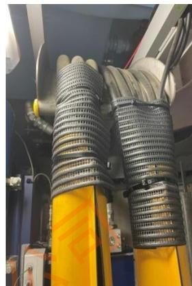
■ 塔架-垂直部高压电缆及通信.控制电缆
