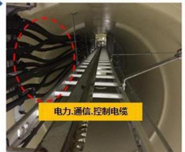
■ 机舱-塔架引出部高压电缆及通信.控制电缆
