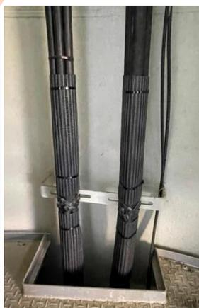
■ 塔架-地面出入口操作盘电源电缆及通信.控制电缆
