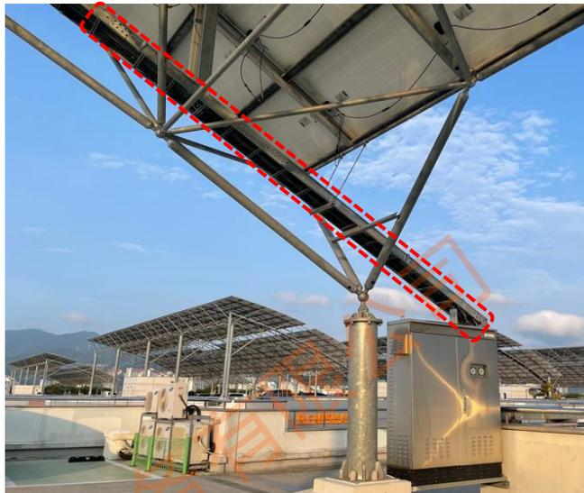
■ 太阳能组件电缆桥架和管道 ( DC Cable Tray & Duct )
